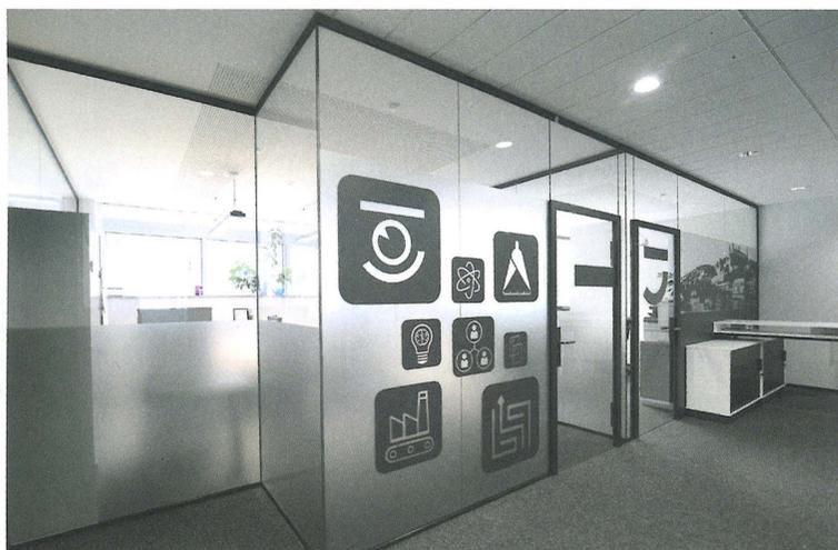
Zwölf Glasdreh Türen realisierte die Glaskel Glasbau GmbH & Co. KG in Würzburg in den eigenen Büros mit dem verdeckt liegenden Bandsystem von BaSys. Dabei kamen drei verschiedenen Farbtöne zum Einsatz, jeweils durchgängig bei Band, Bandkasten, Schloss, Schlosskasten, Türdrücker, Zarge sowie den Profilen. Foto: The Design Patrick Banasik | [www.basys.biz](http://www.basys.biz)
