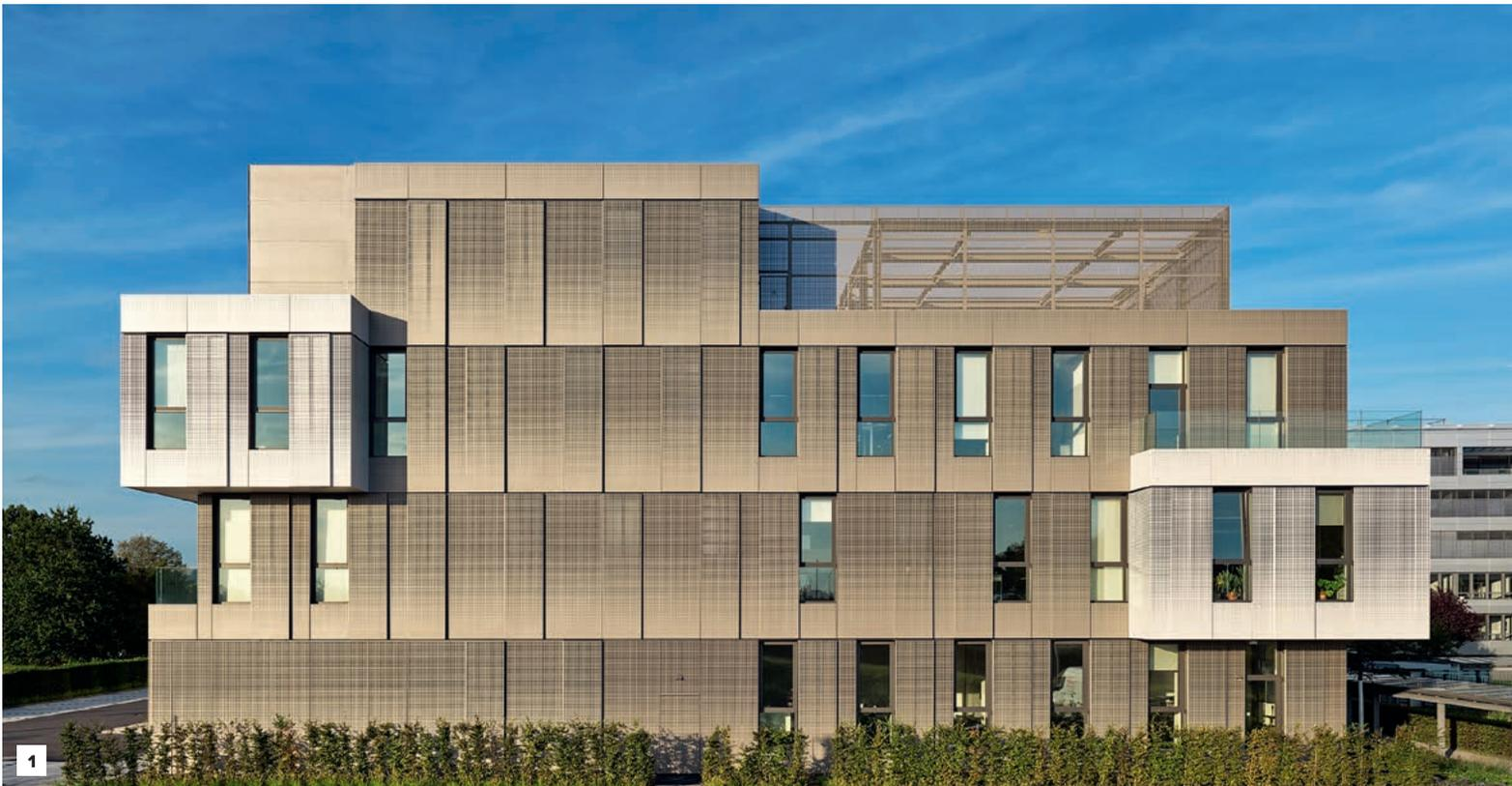
**Ein Gebäude in Modulbauweise zu errichten, kann für Bauherren auch bei grösseren Bürobauten handfeste Vorteile bieten. So haben Scope Architekten beim Softwarehersteller SAP in Walldorf bei Heidelberg ein viergeschossiges Bürogebäude mit einer Fläche von 10 000 m<sup>2</sup> errichtet, dessen Grundstruktur aus einem vorgefertigten, teilausgebauten Stahlskelett in lediglich acht Wochen aufgestellt werde. Eine besondere Rolle kommt dabei der vorgehängten Fassade zu.**
