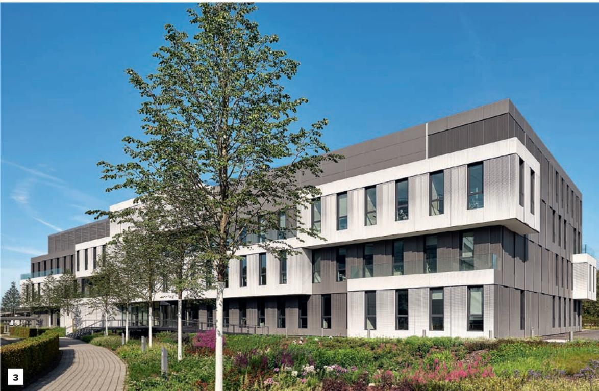
betont wird. Nähert man sich dem Gebäude, zeigt sich, dass die Aussenhaut aus einer Lochblechfassade besteht, deren Lochung pro Stockwerk von oben nach unten fließend variiert, wodurch sich umgekehrt die Durchsichtigkeit von unten nach oben vergrößert. Der Lochgrößen-Verlauf wurde gemeinsam mit den renommierten Klimatechnologie-Planern von Transsolar aus Stuttgart anhand des Sonnenverlaufs entwickelt, um einen optimalen Sonnenschutz für die Räume dahinter zu erreichen. In Zahlen ausgedrückt:
